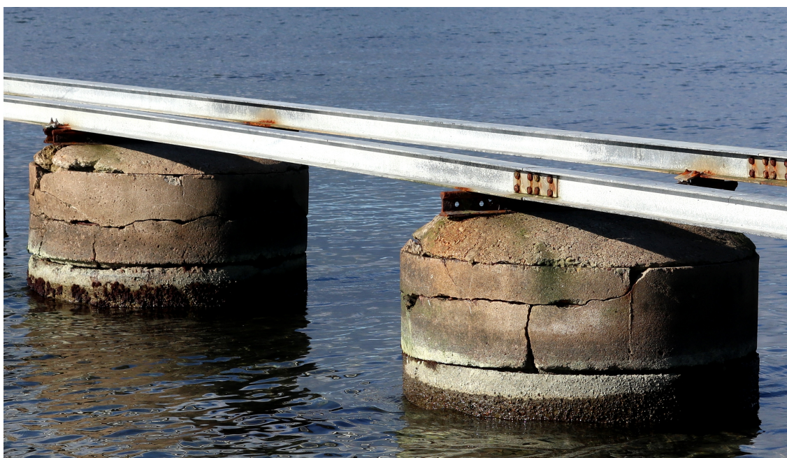
Tvärjärnen rostar sönder och betongplintarna spricker.
