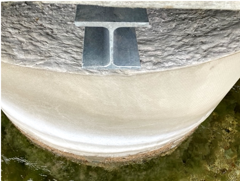
Foto nr. 20 Stöd: 4 – Detaljfoto efter utförd formrivning.
