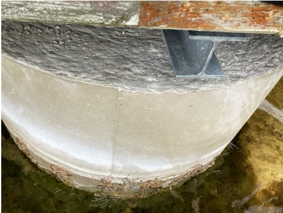
Foto nr. 19 Stöd: 3 – Detaljfoto efter utförd formrivning.
